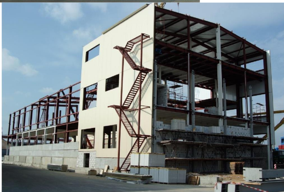
Здание АБК ОАО «Жабинковский сахарный завод», г.Жабинка, Брестская обл.
